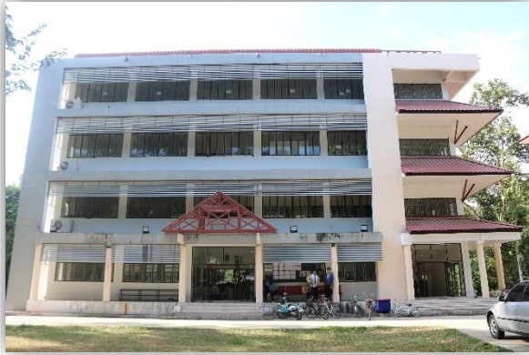
อาคารแผนกวิชาคอมพิวเตอร์ธุรกิจและแผนกวิชาเทคโนโลยีสารสนเทศ
