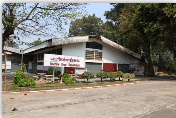
อาคารแผนกวิชาช่างกลโรงงาน
