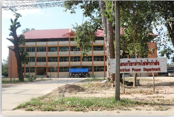
อาคารแผนกวิชาไฟฟ้ากำลัง
